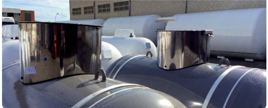
ARQUETAS DEPÓSITOS ENTERRADOS
